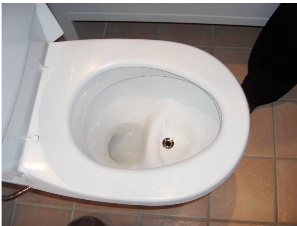
Figuur 15 Een no-mix-toilet voor het gescheiden opvangen van urine en feces (bron: STOWA, Bjartur Swart)
