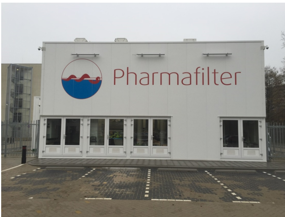
Figuur 14 Pharmafilter zuiveringsinstallatie, Reinier de Graaf Gasthuis, Delft (bron: Pharmafilter)
