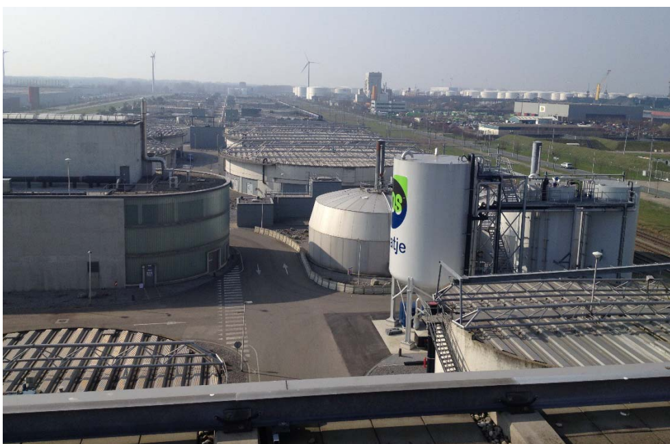
Figuur 13 Rwzi Amsterdam-West met op de voorgrond de fosfaat-opslagtank (bron: Waternet)
