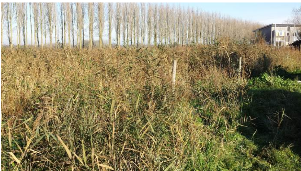
Figuur 17 Helofytenfilter in de wijk Drielanden in Groningen (bron: STOWA, Bjartur Swart)
